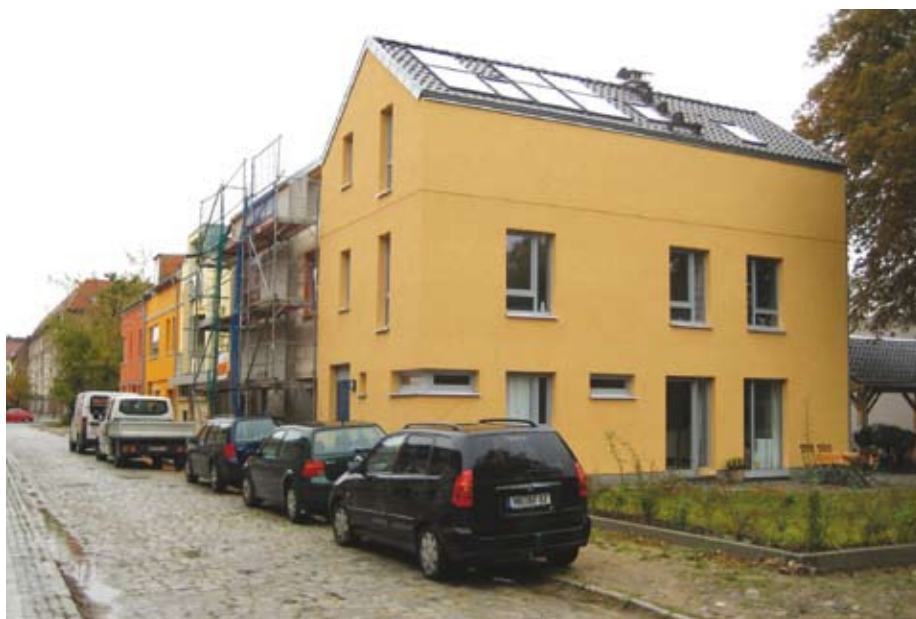
Alle Häuser haben Gärten. Am Haus Nr. 23 ist er seitlich angeordnet, so dass sich ein schöner Blick auf die Stadtmauer ergibt (Architektin: Susann Milatz)
